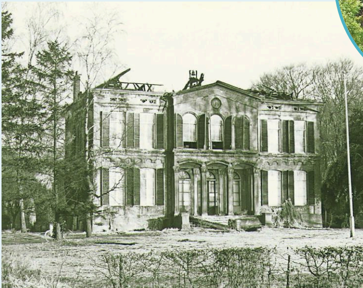
Het echtpaar kocht Wientjesvoort in 1999: een bouwval die na een schoorsteenbrand in 1968 al ruim dertig jaar stond te verloederen.
